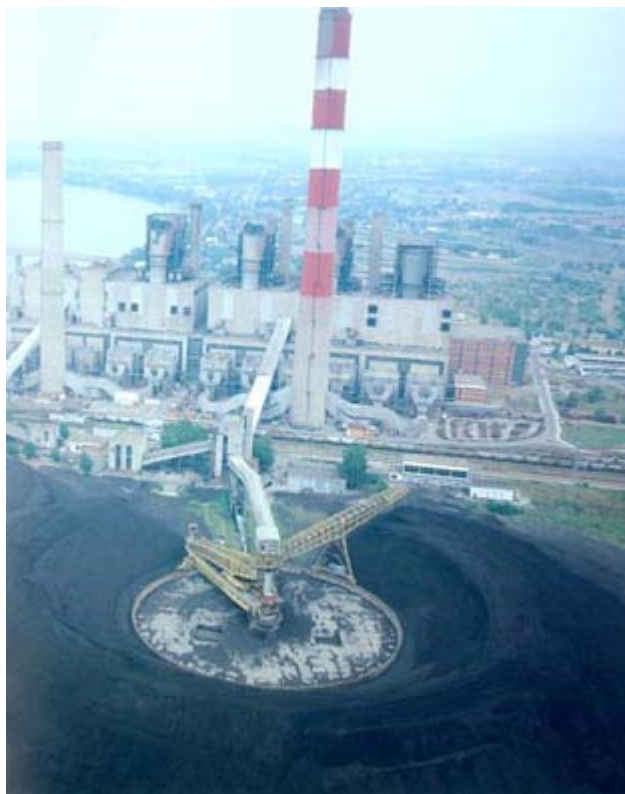
Slika 3-5 Termoelektrana "Nikola Tesla" A
