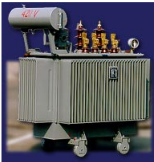
Slika 7-1 Trofazni distributivni transformator
