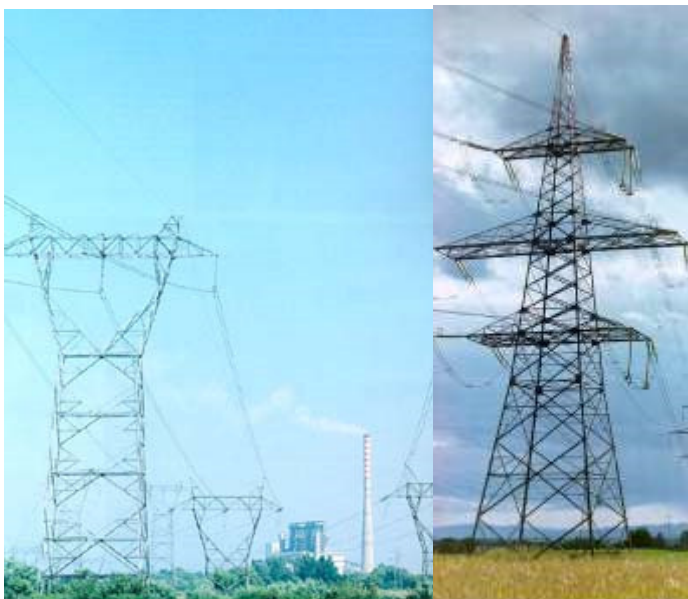
Slika 4-6 Dalekovodi u prenosnoj mreži
