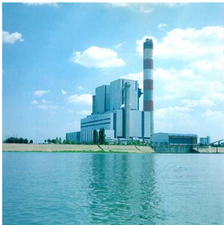
Slika 3-6 Termoelektrana "Nikola Tesla" B
