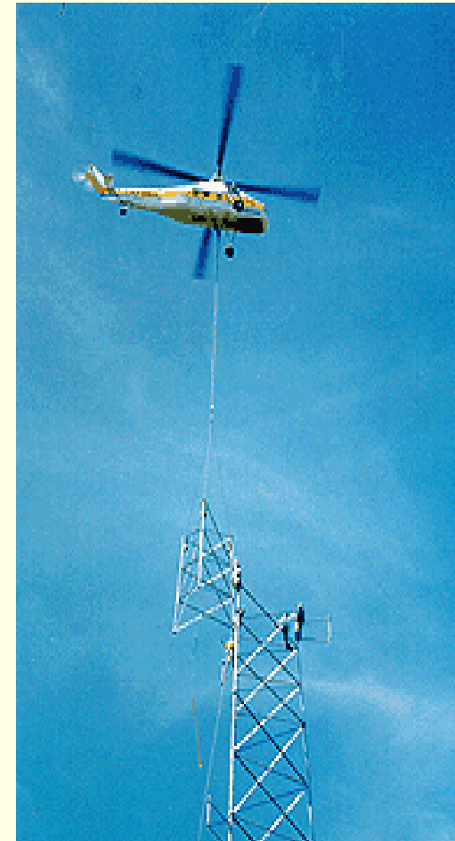
Slika 2.8. Podizanje stubova pomoću helikoptera
