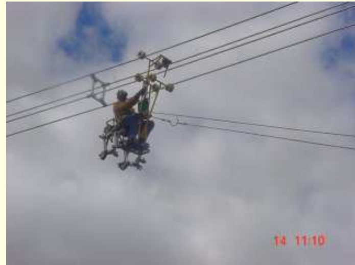
Slika 2.15. Montiranje rastojnika
