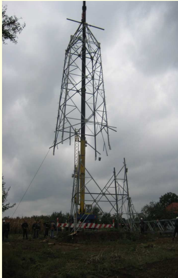
Slika 2.7. Podizanje stuba pomoću dizalice
