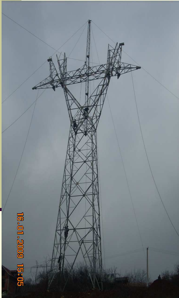
Slika 2.6. Podizanje stuba pomoću montažne igle
