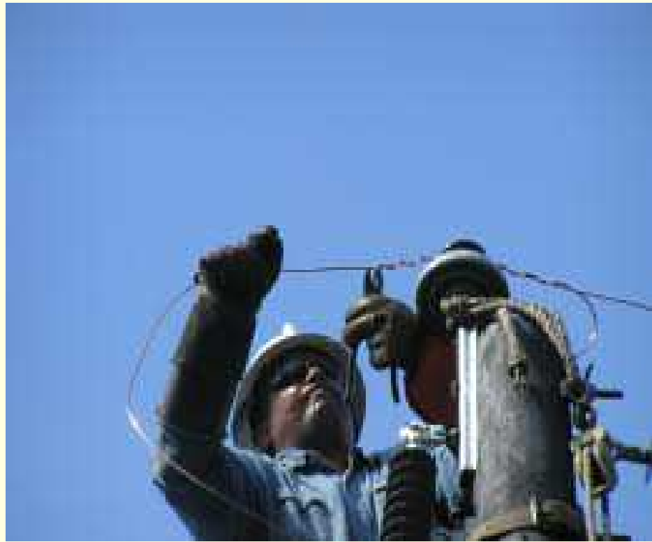
Slika 2.10. Montiranje nosača izolatora i izolatora na stub
