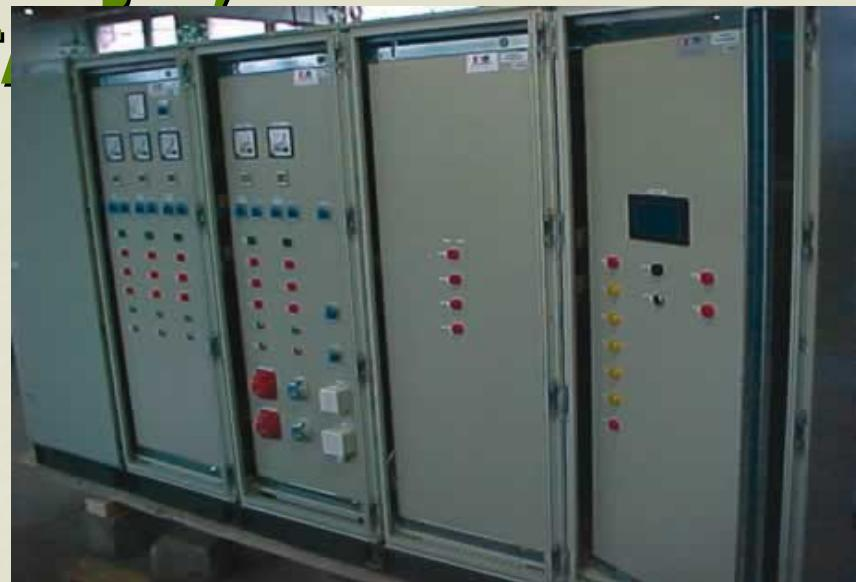
PLC takođe vodi proces vremenskog zatezanja izmedju uključenja pumpi, kao i to da ne smeju da rade istovremeno preko četiri pumpe. OMRON touch terminala - Na ovom operator panelu korisnik može da prati svu sinoptiku ovog procesa prepumpavanja, od broja radnih sati pumpi, trenutno prisutne alarme u sistemu, istoriju alarma, trenutni nivo u rezervoaru, uzrok ispada pojedinih pumpi do resetovanja brojača i zadavanja početne vodeće pume.
