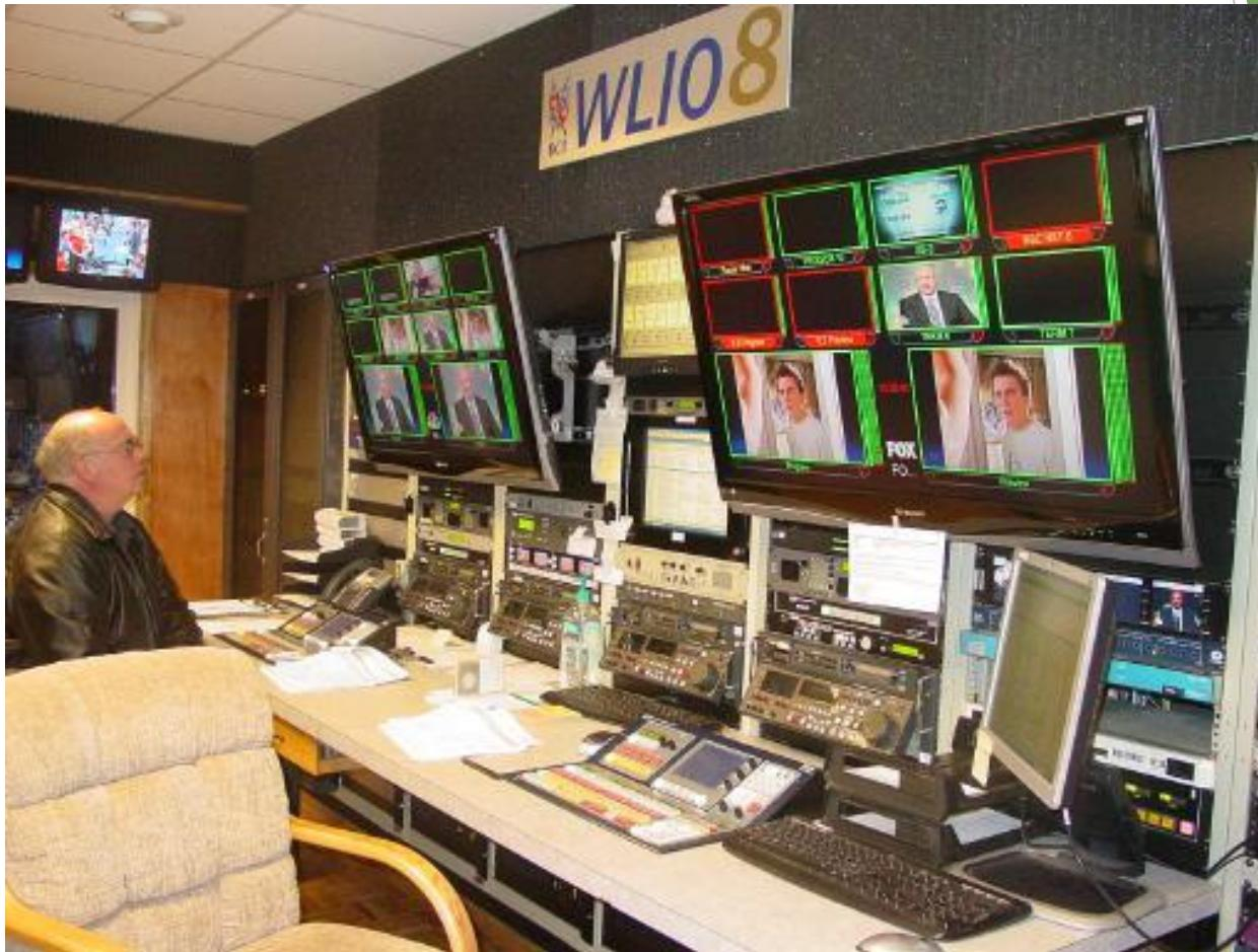
режија емитовања са хибридним решењем тј. паралелном употребом магнетоскопа и сервера за емитовање
