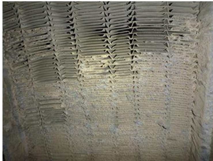
Detaljni prikaz strukture zapljanog „saća“
