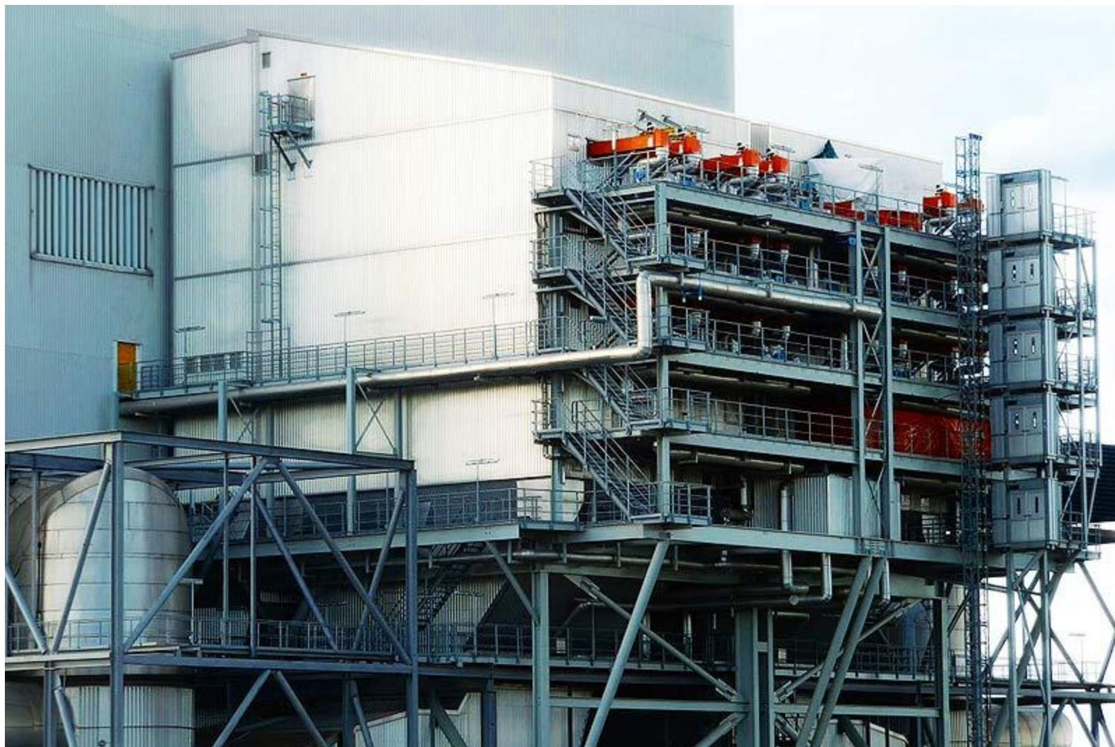
SCR postrojenje firme Steinmuller Babcock Environment za 650 MW parni blok
