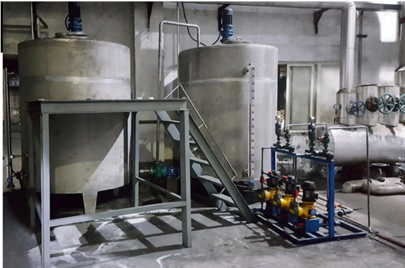
Izgled jednog realnog postrojenja za denitrifikaciju bazirano na SNCR reaktoru, proizvodnje HENAN SUNGSUNGS –Kina; Postrojenje za denitrifikaciju na spaljivaču manje snage
